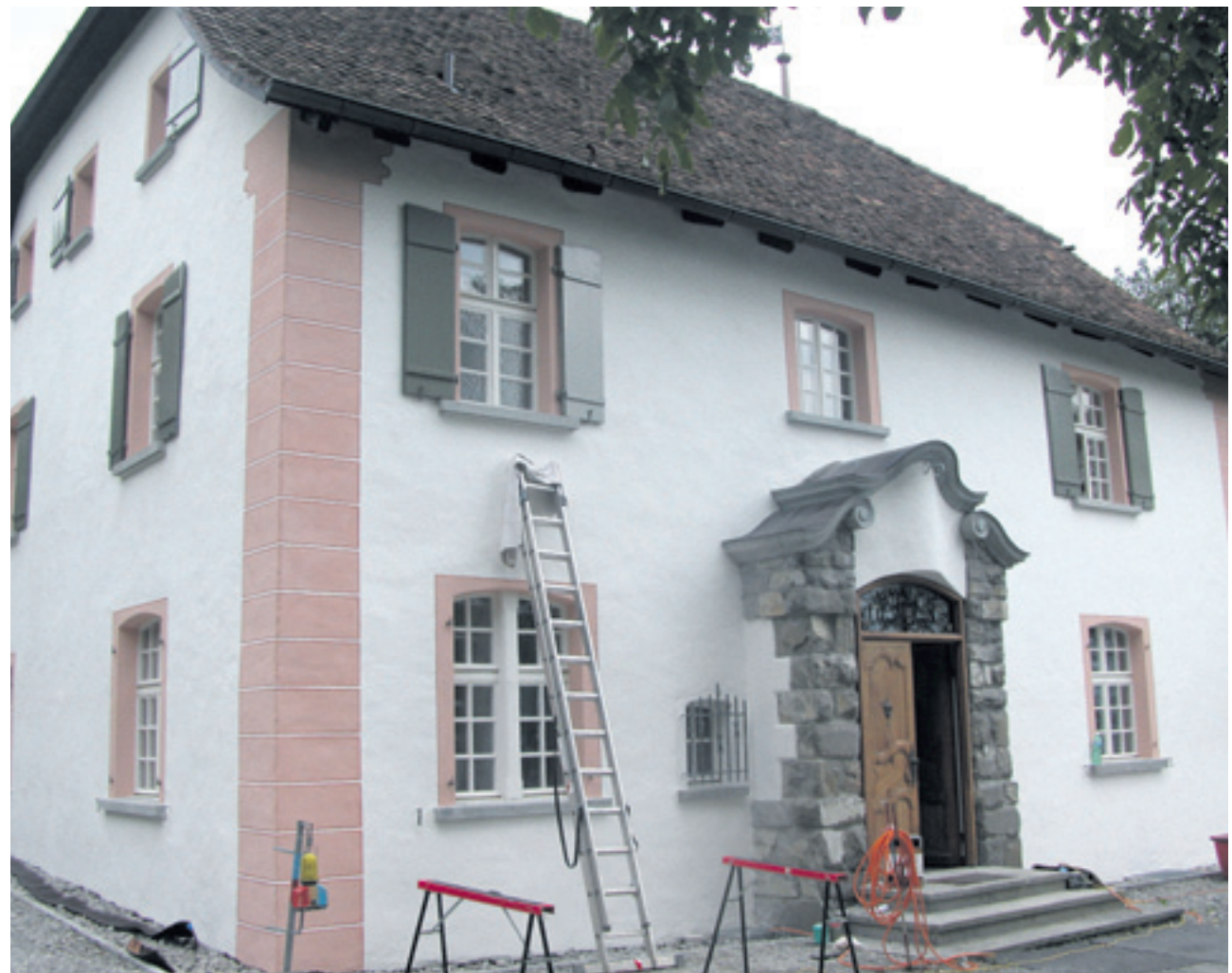
Die Renovationsarbeiten sind fast abgeschlossen: Der Gamanderhof in Schaan erstrahlt mit neuer Aussenfassade in neuem Glanz. Die Restaurateure hielten sich an die historischen Vorlagen.
